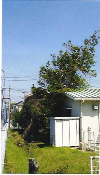
西小学童保育の建物に覆い被さる倒木
